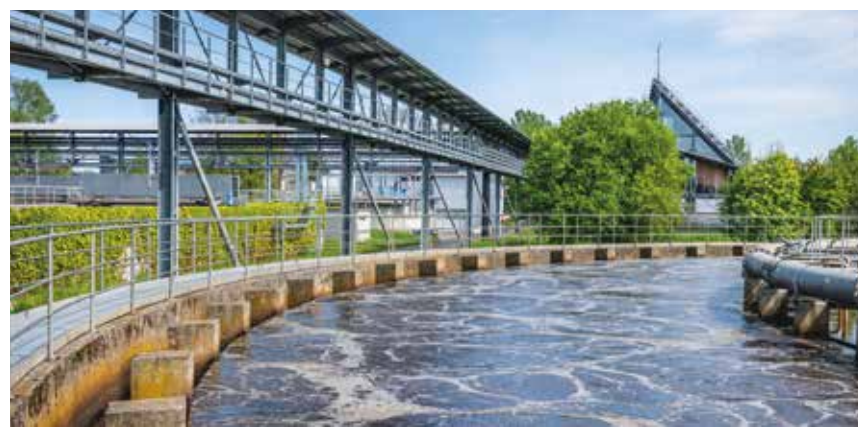
Im Schachtelbecken arbeiten Milliarden Bakterien an der biologischen Reinigung des Abwassers.
