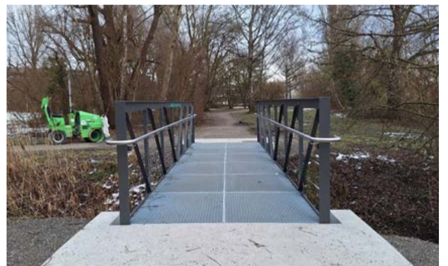
Neue Brücke am Uferweg in Stromeyersdorf fertiggestellt: Eines der vielen lauschigen Plätzchen am Konstanzer Seerhein ist der Uferweg im Gewerbegebiet Stromeyersdorf. Nachdem dort eine marode Holzbrücke als verbindendes Element zwischen dem Gelände des Kleingartenvereins und der Bleiche aus Sicherheitsgründen abgerissen werden musste, hat die Stadt Konstanz einen Fußgängersteg mit stählernem Fachwerk installiert. Der Steg ist acht Meter lang und 1,80 Meter breit.
