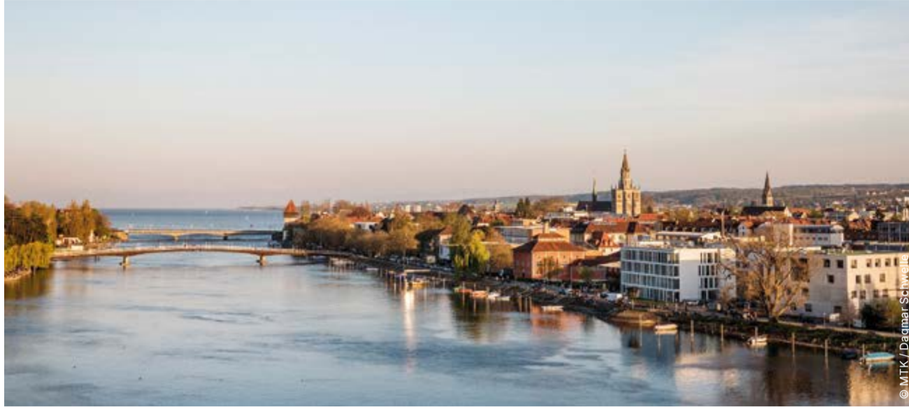
Aus dem Bodensee gewonnene Wärme steht als Energiequelle für den Wärmeverbund rund um die Bodensee-Therme im Fokus.
