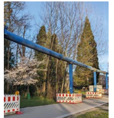
Die oberirdische Abwasserleitung wird vor dem Abbau noch gründlich gespült.
