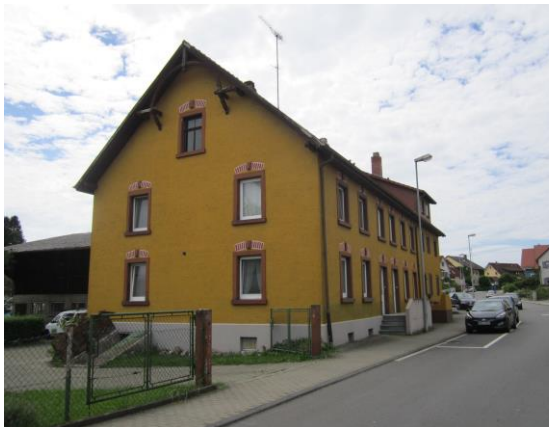
Abb. 34: Wohngebäude – Allensbacher Straße
