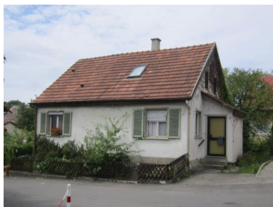
Abb. 21: Wohnhaus – Zum Butzen
