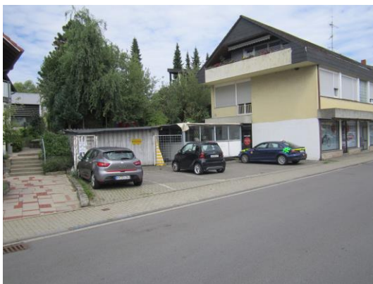
Abb. 41: Hofbereich – Allensbacher Straße
