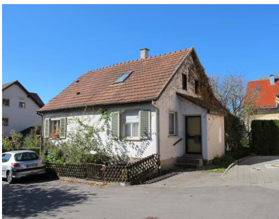
Abb. 29: Wohnhaus – Zum Butzen
