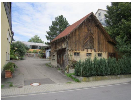
Abb. 20: Schuppen – Allensbacher Straße
