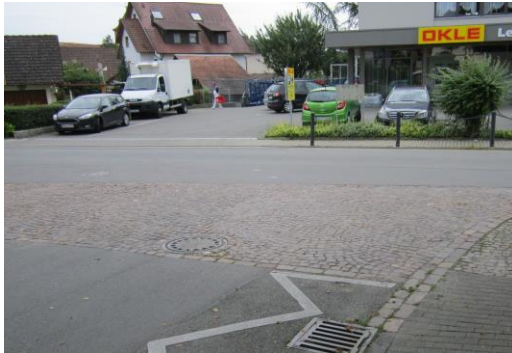
Abb. 15: Unübersichtlicher Kreuzungsbereich – Allensbacher Straße/Schulweg
