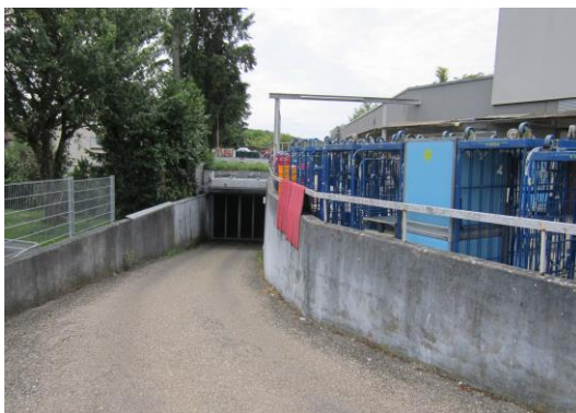
Abb. 16: Tiefgaragenzufahrt, Allensbacher Straße
