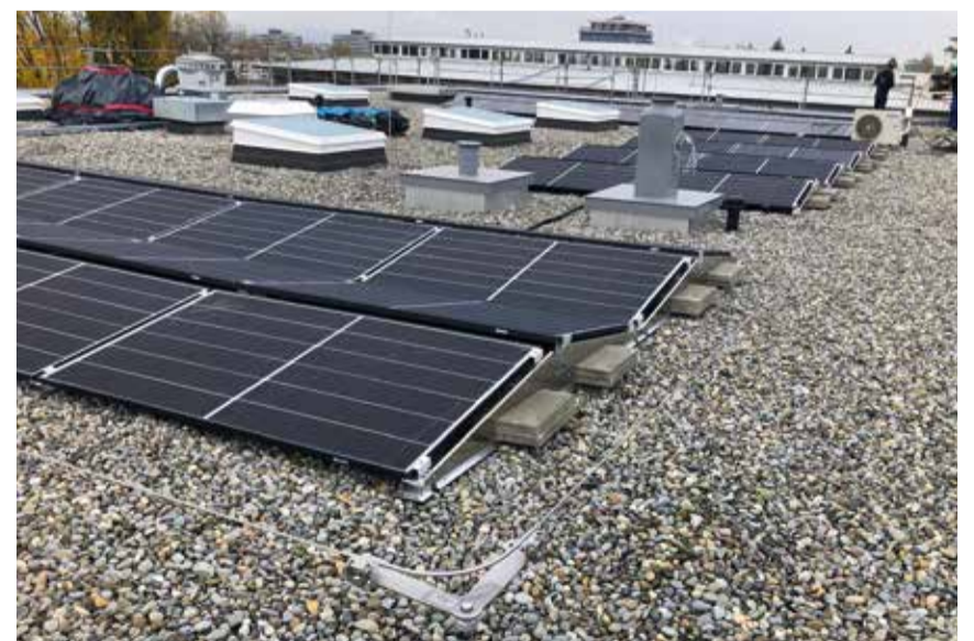
Ein weiterer Beitrag zum Ausbau der erneuerbaren Energiequellen: Auch der Erweiterungsbau für die Oberstufe der Gebhardschule hat nun „eine aufs Dach bekommen“ – die neu installierte Photovoltaik-Anlage besteht aus 70 PV-Modulen und erbringt eine Höchstleistung von bis zu 27,3 kWp (Kilowatt-Peak) im Jahr. Der PV-Strom wird direkt in das moderne Gebäude eingespeist.
