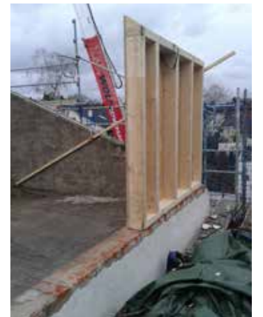
Der Dachstuhl wurde komplett abgebrochen und das Dachgeschoss mit Holz- wänden neu erstellt und gedämmt.
