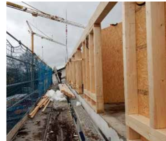
Der Dachstuhl wurde komplett abgebrochen und das Dachgeschoss mit Holz- wänden neu erstellt und gedämmt.
