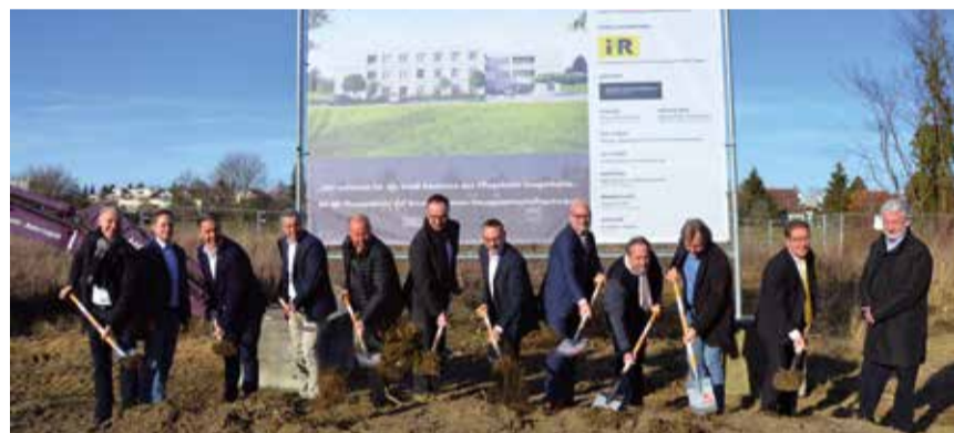
Der erste Spatenstich für das Pflegeheim an der Jungerhalde ist erfolgt.
