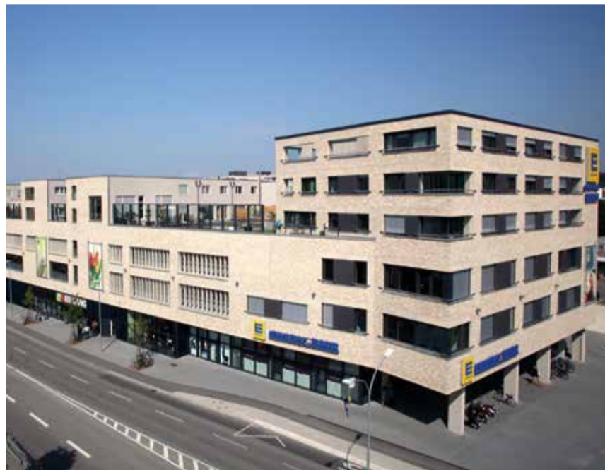
Gelungenes Projekt: 48 Eigentumswohnungen auf dem EDEKA Baur in der Reichenaustraße
